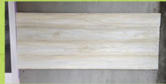
浮造を既設壁に再現
