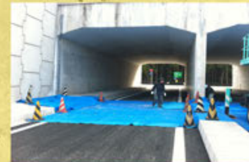
土木工事にも
