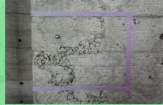
杉板模様の修繕
